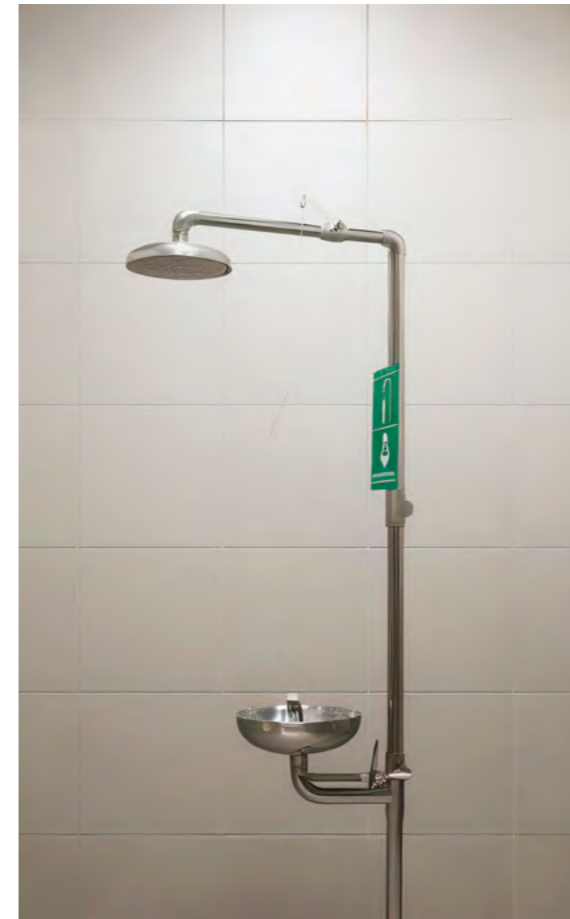
Lavaojos y duchas de emergencia
